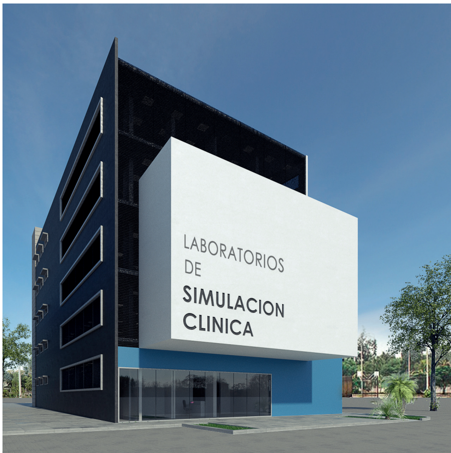
FIGURA 01: EDIFICIO LABORATORIOS DE SIMULACIÓN CLINICA – UBICADO EN EL CAMPUS UNIVERSITARIO
