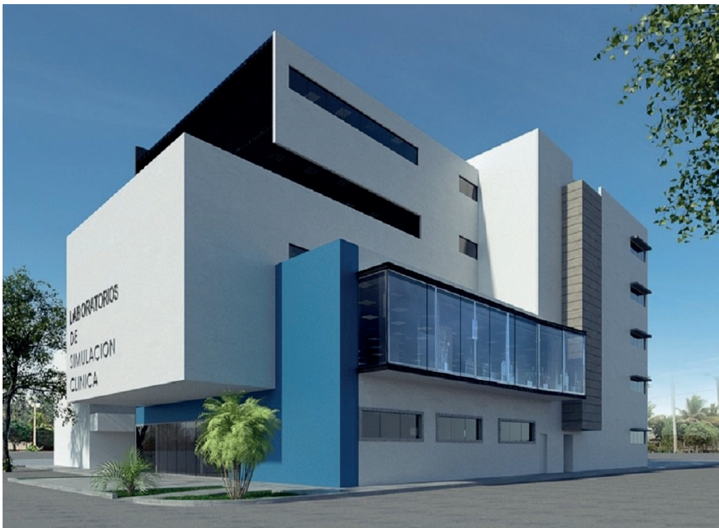
FIGURA 02: EDIFICIO LABORATORIOS DE SIMULACIÓN CLINICA – UBICADO EN EL CAMPUS UNIVERSITARIO.
