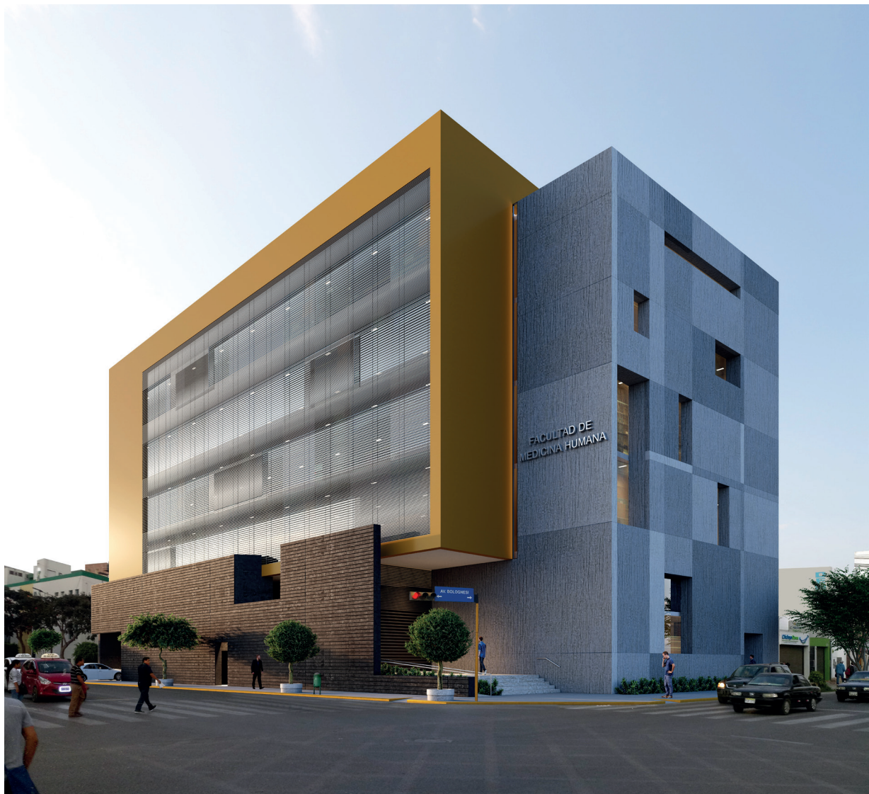
FIGURA 01: EDIFICIO LABORATORIO DE CIENCIAS CLÍNICAS – UBICADO EN LA CIUDAD DE CHICLAYO
