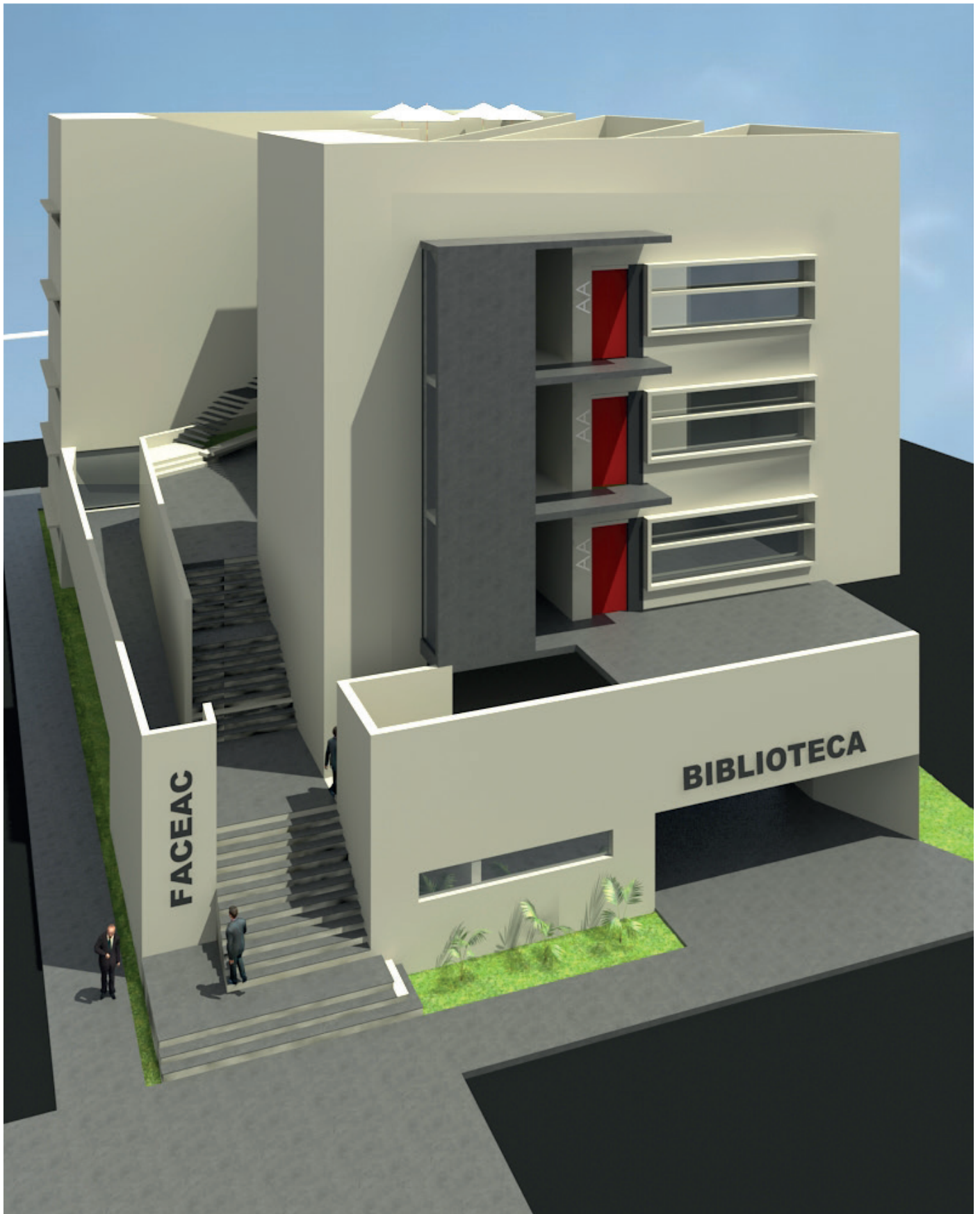
FIGURA 02: EDIFICIO LABORATORIOS DE SIMULACIÓN CLINICA – UBICADO EN EL CAMPUS UNIVERSITARIO.
