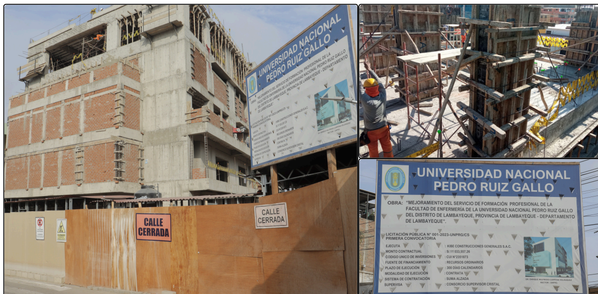
Construcción del nuevo edificio de laboratorios FE - UNPRG
